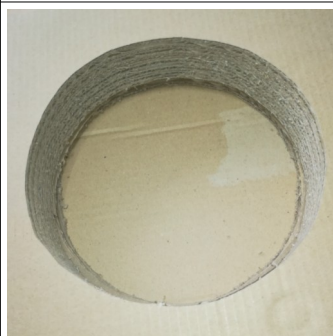
Mit der Stichsäge aussägen
